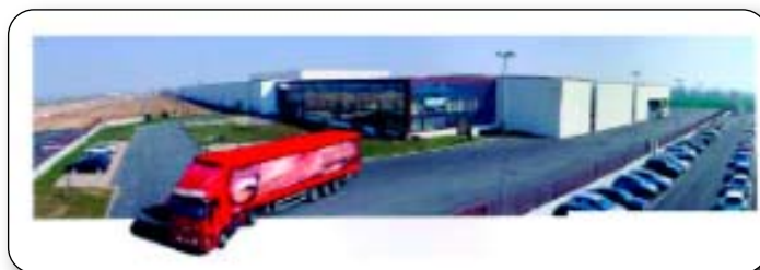
La piattaforma logistica di Cherasco
