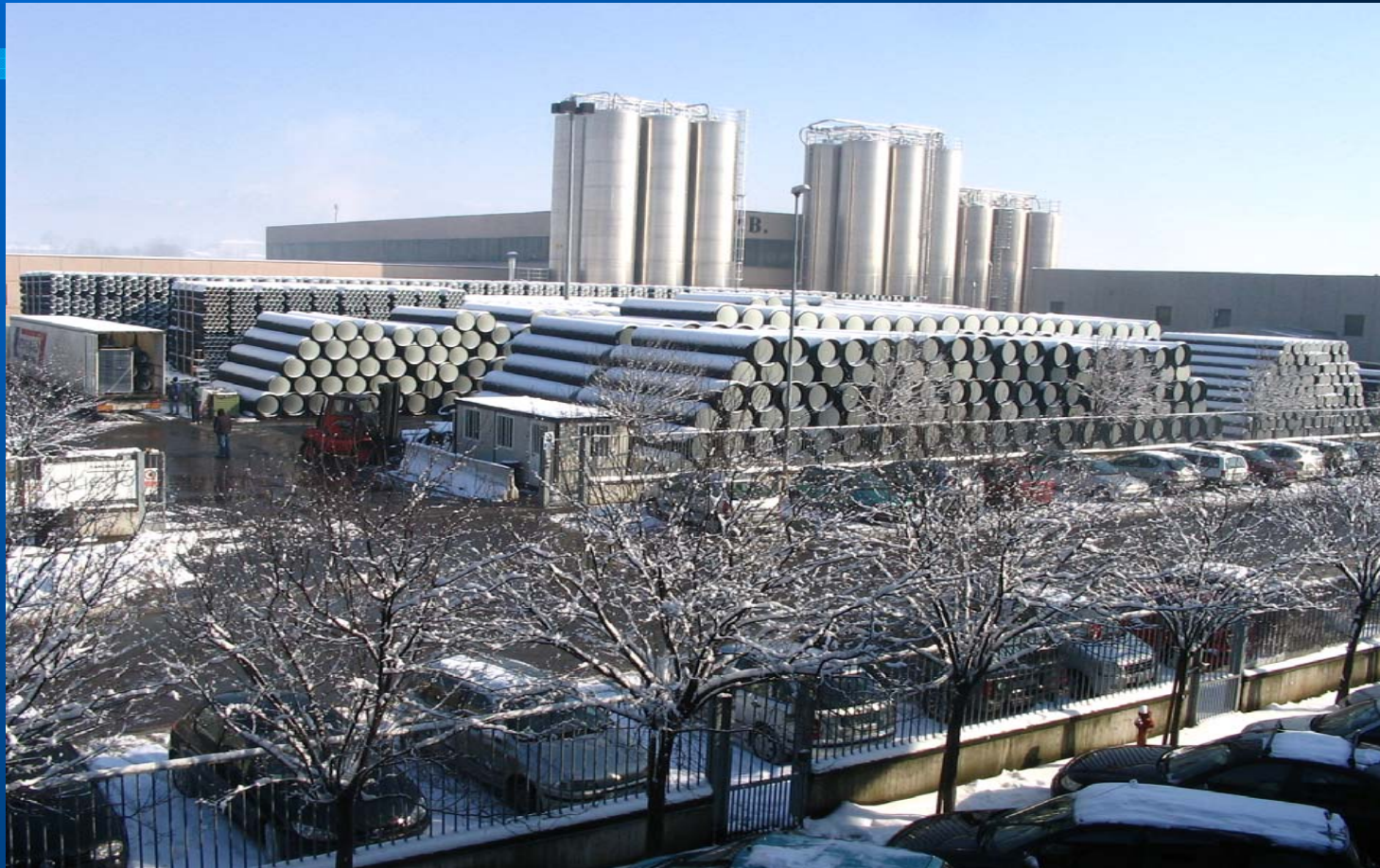
Stabilimento di Cazzago SM veduta Nord
