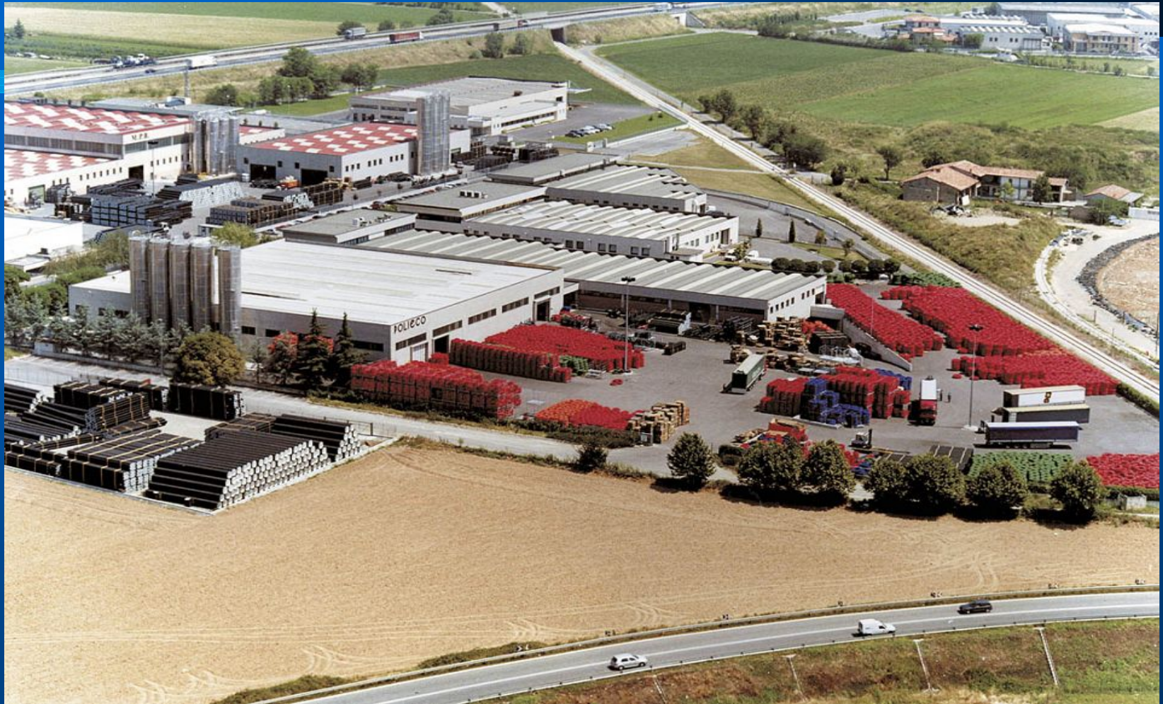
Stabilimento di Cazzago SM veduta Sud
